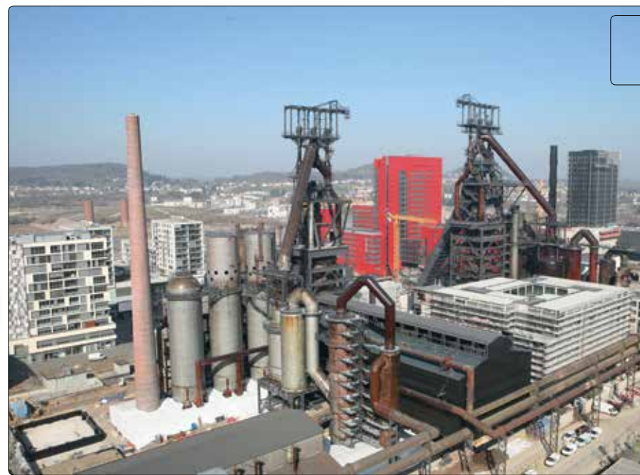
Auf dem Areal des stillgelegten Stahlwerks Belval im Süden Luxemburgs entsteht eine Stadt der Wissenschaft, Forschung und Innovation.
