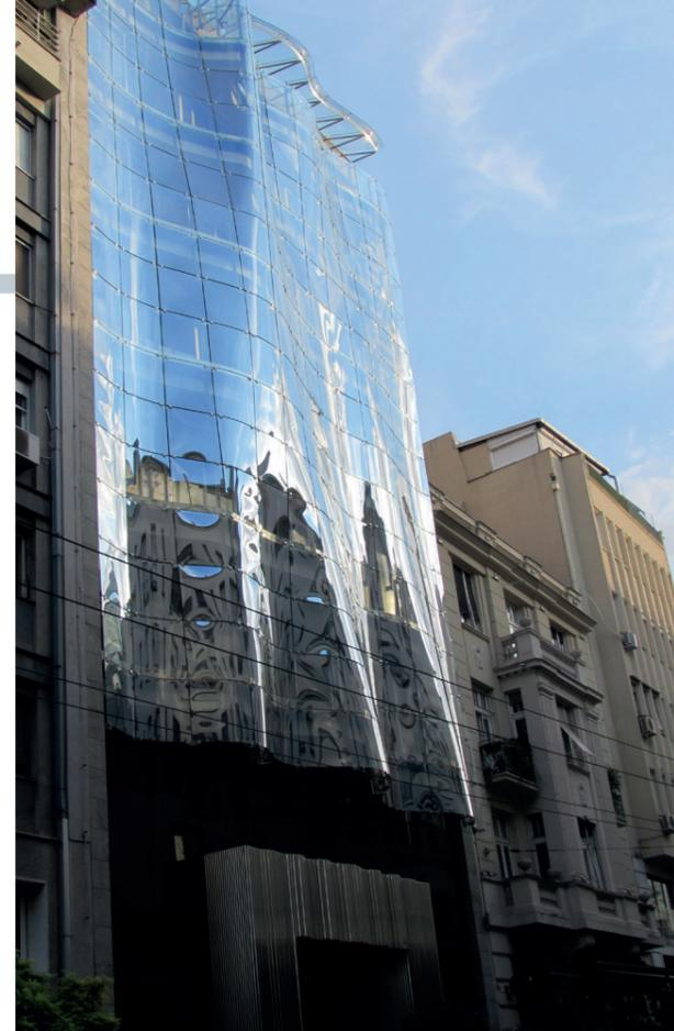
← Angesichts von zuletzt 45 Grad ist die Wand- und Deckenkühlung im Wohnprojekt Infinity sehr gefragt, im Winter wird mit Geothermie via Boden und Wand geheizt. Die doppelte Glasfassade schafft ebenso Energieeffizienz.
