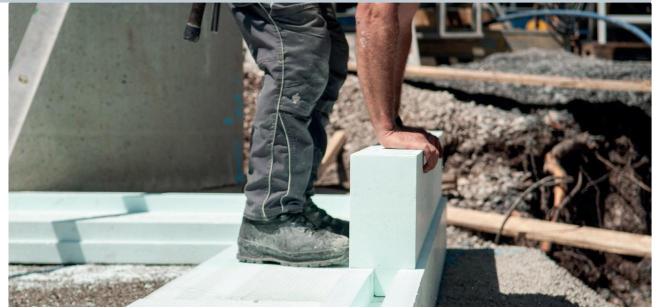
**Fortschritt bei hoher Druckbeanspruchung:** Das Eco-System steinodur SHD 500 von Steinbacher gewährleistet eine lückenlose Dämmung zwischen Perimeterbereich und Bodenplatte.
